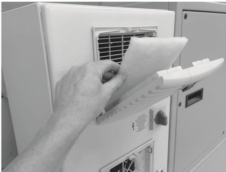
Fig. 39: filterbytte koblingsskap
